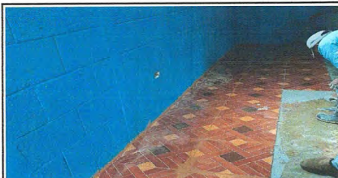
Foto 6: Cambio de piso a piso cerámico aulas.
