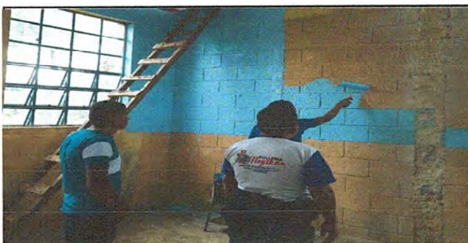
Foto 5: Cambio de pintura
