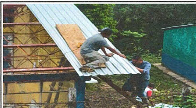
Foto 2: Cambio de cubierto modulo II
