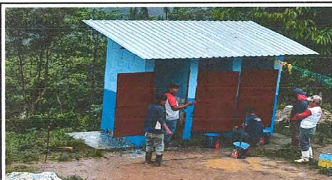
Foto 3: Cambio de pintura y cubierto de baños
