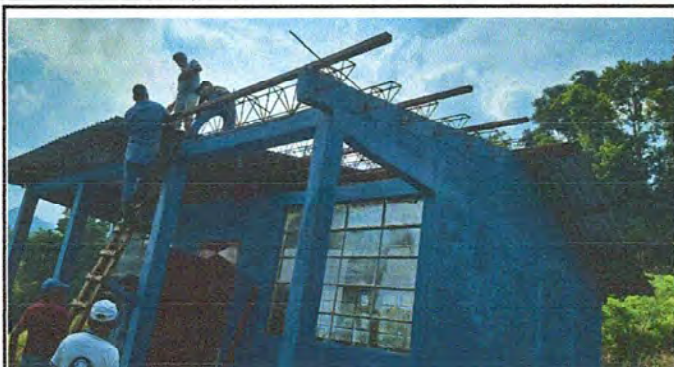
Foto1: Cambio de cubierto modulo I
